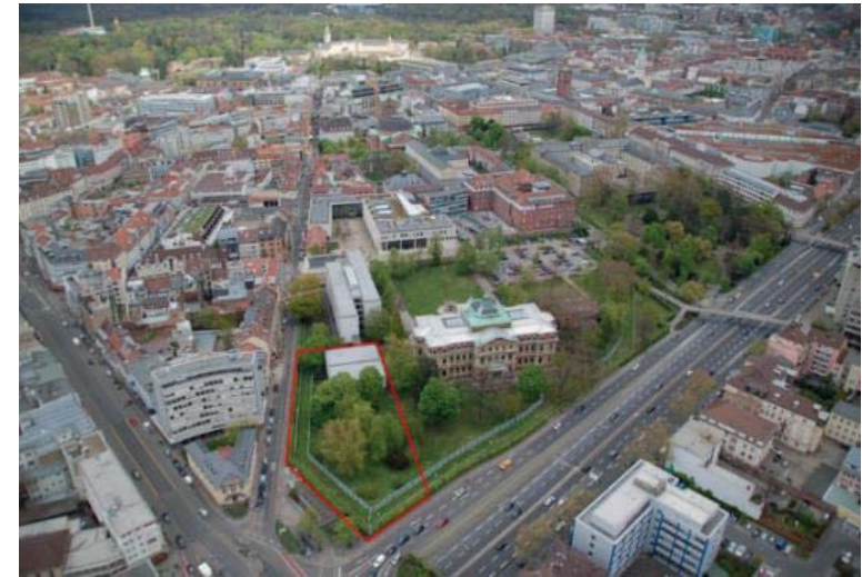
Vorgesehenes Baugelände für das Forum Recht auf dem BGH-Areal
