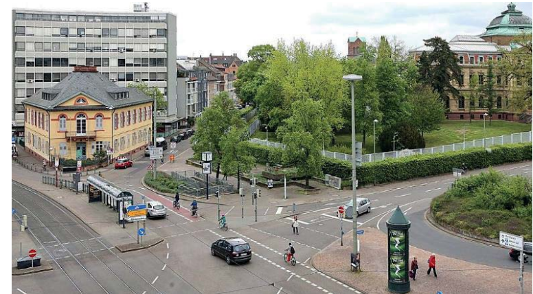
Baugelände am Karlstor
